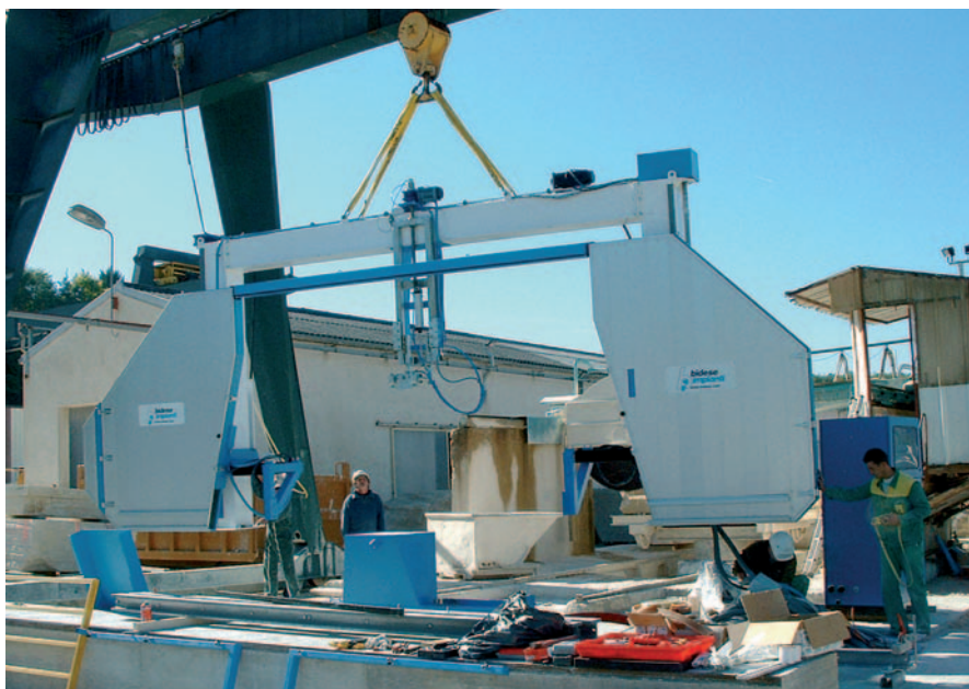
► Installation sur le site de l'entreprise Sogepierre d'une machine à fil diamanté New 4000 Spécial, montée sur rails.
