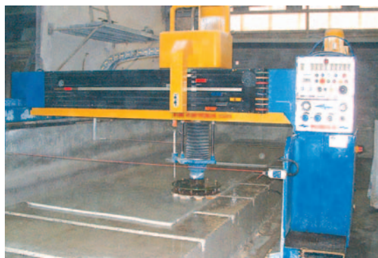
▲ Réinstallation et remise aux normes de sécurité sur le polissoir à plat Zambon de chez DBPM .
